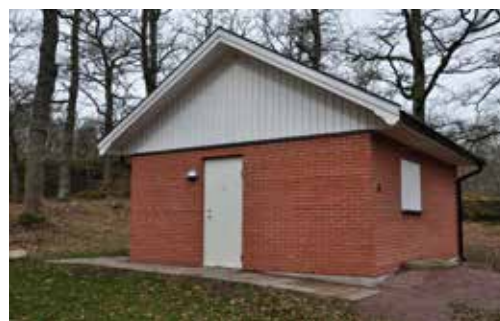
Serviceanläggningen som byggts av Dackeskolans elever
